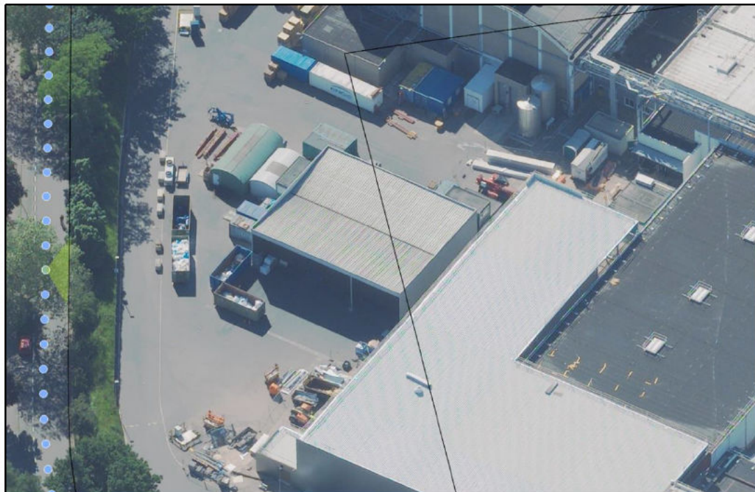
Figuur II.1 Luchtfoto palletloods (zicht op de oostzijde)
